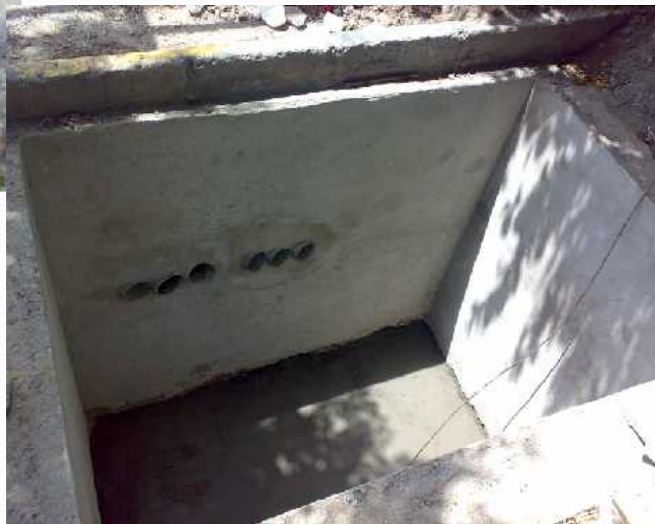
حوضچه آماده شده برای نصب پست دفنی
