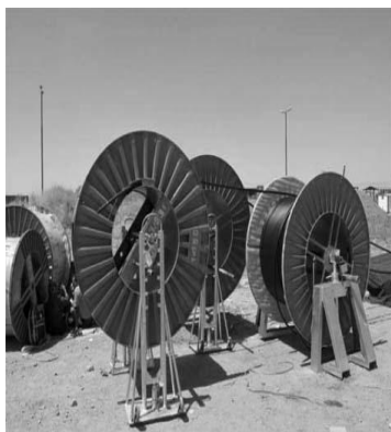
شکل (۹) قرقره کابل کشی
